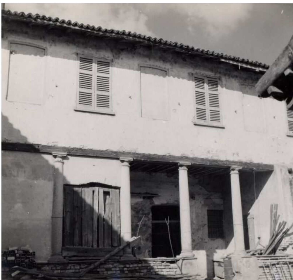
Vista interna Cascina Castello – Cortile interno della Casa del Fittabile (1953)
