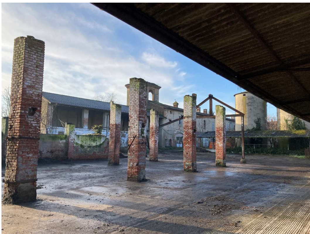
Viste incendio fienile (foto recente)
