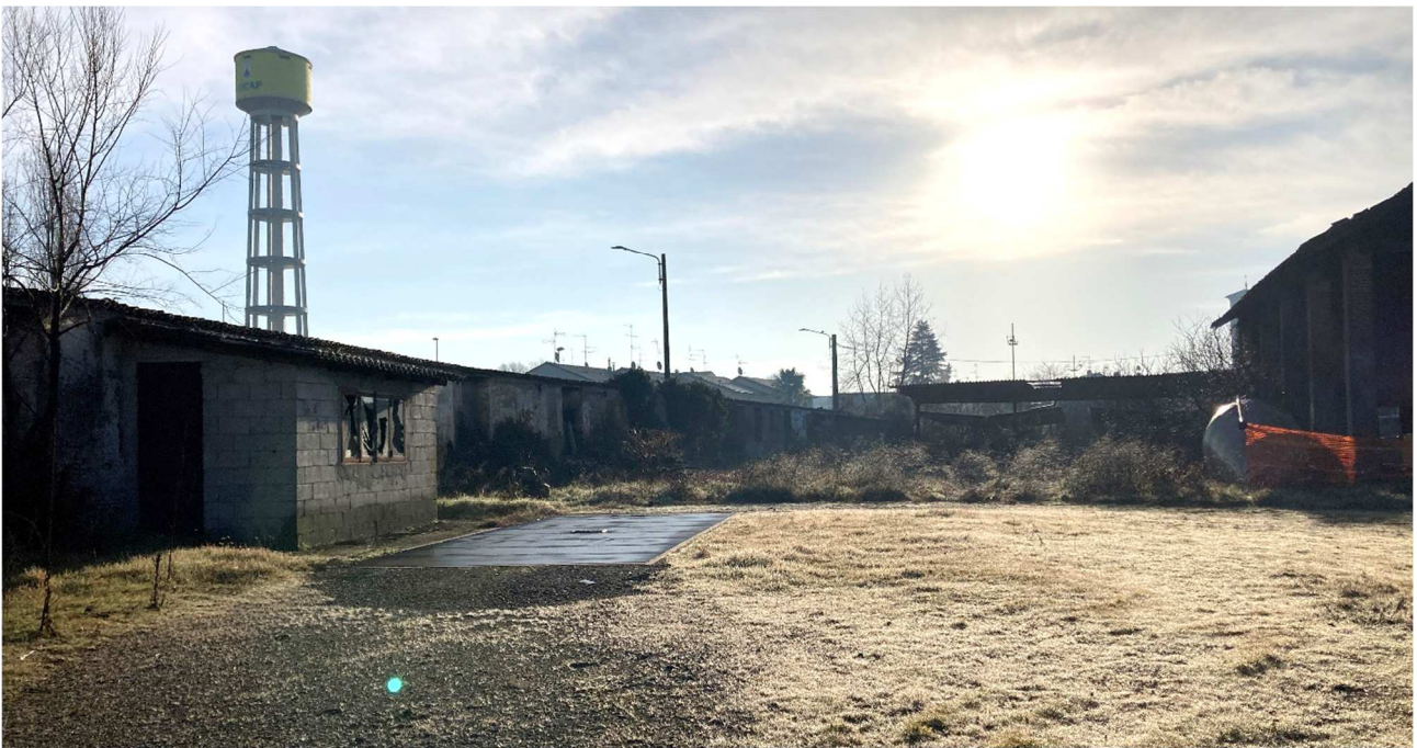
Vista interna Cascina Castello – Pesa – Area ex-fabbricato demolito (foto recente)
