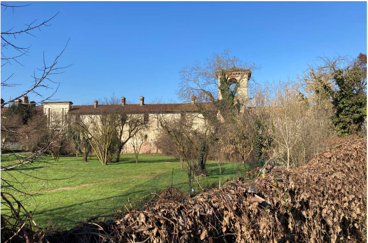
Vista Cascina Castello - fronte via Torchio (foto recente)
