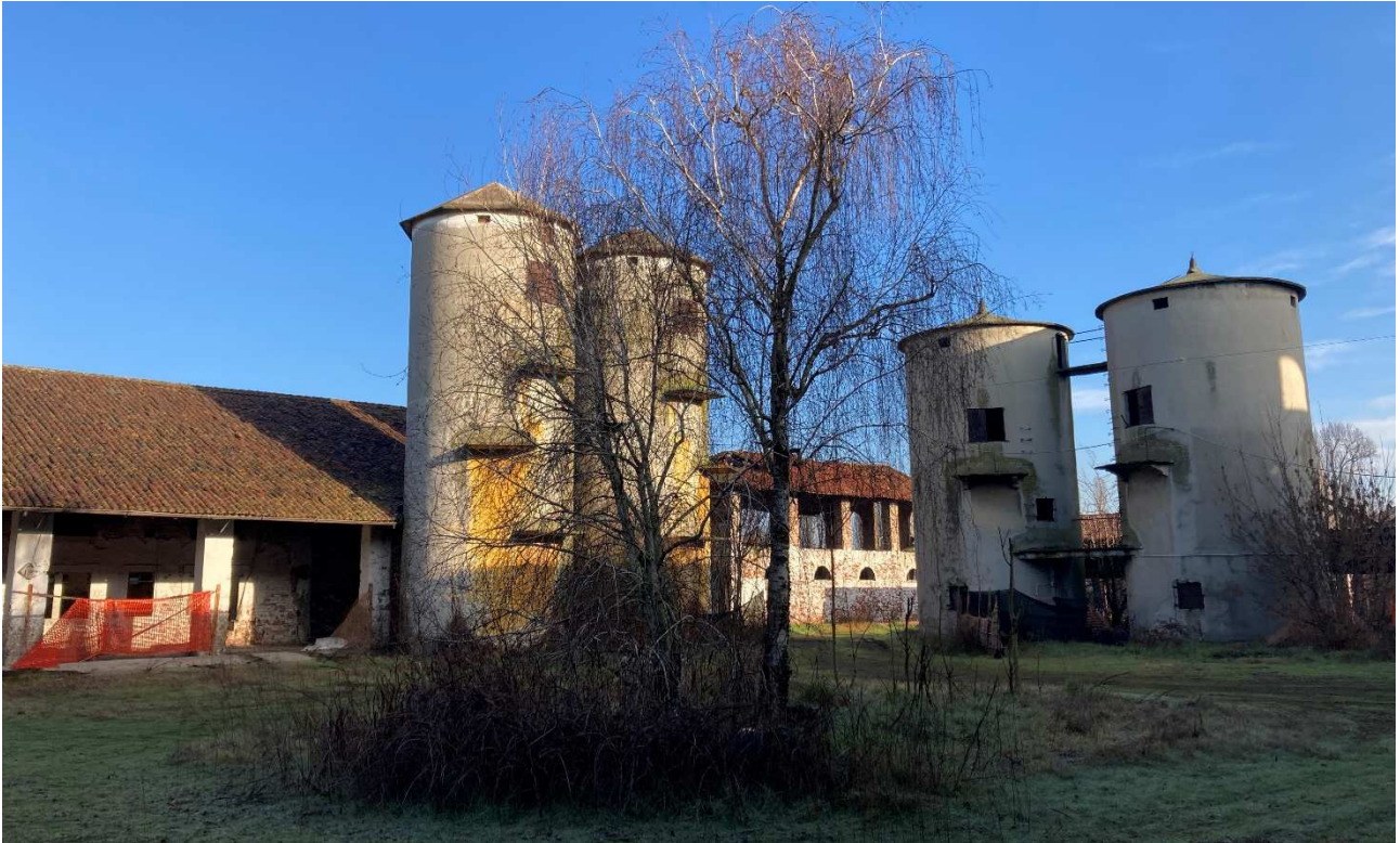
Vista interna Cascina Castello – Silos (foto recente)
