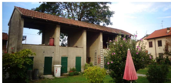
Viste Rustico delle Case Coloniche (foto recente)
