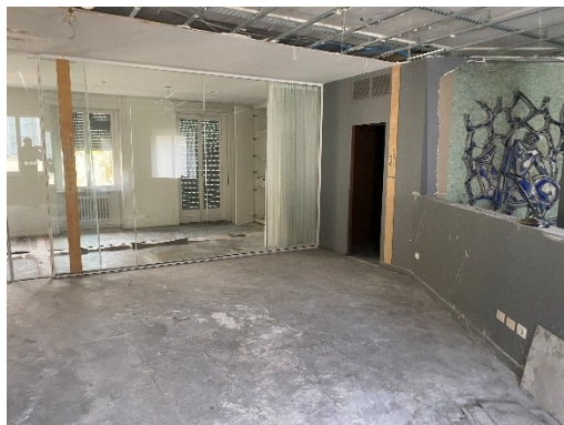
21 Uffici sopra autorimessa
