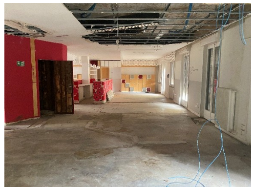
22 Uffici sopra autorimessa
