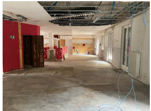
22 Uffici sopra autorimessa
