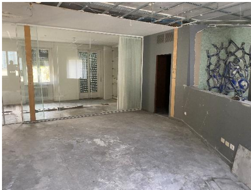
21 Uffici sopra autorimessa
