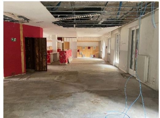
22 Uffici sopra autorimessa
