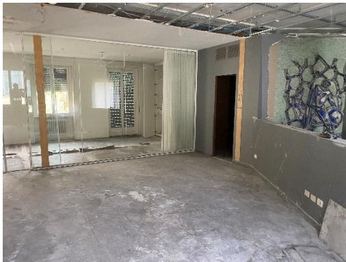
21 Uffici sopra autorimessa
